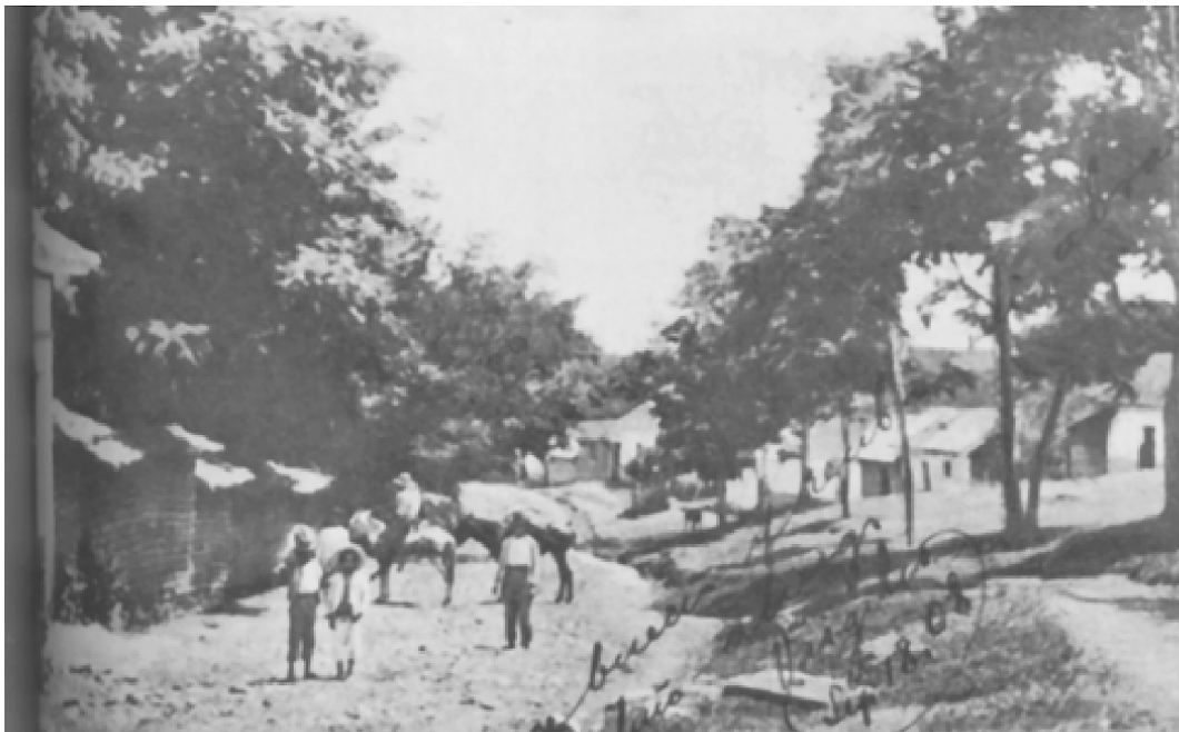
Ilustración 3. Vista de la antigua Carrera 4 con Calle 2, A la derecha se observa el lugar donde actualmente se encuentra el Parque Isaias Gamboa. Tomado de Calero (1983)
