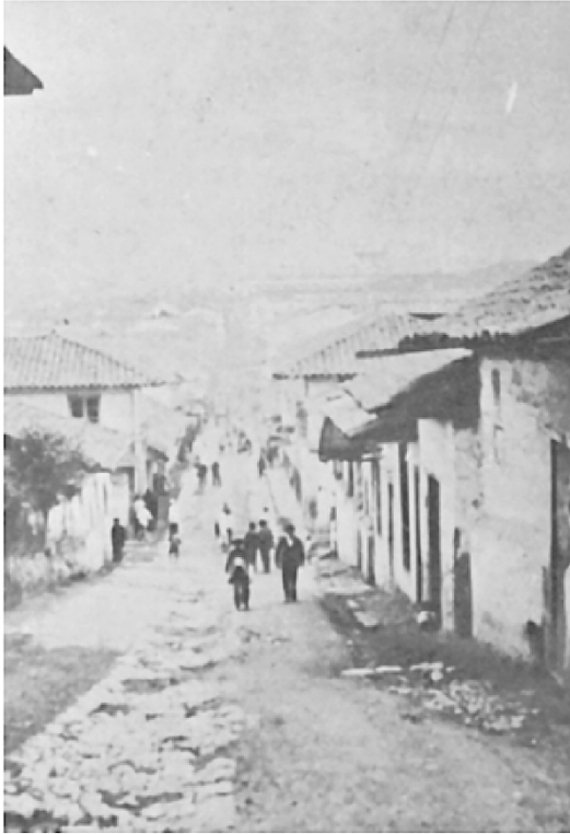
Ilustración 4. Calle de San Antonio a finales del siglo XIX. En el centro de la calle se observa el drenaje de aguas negras y lluvias. Tomado de Calero (1983).
